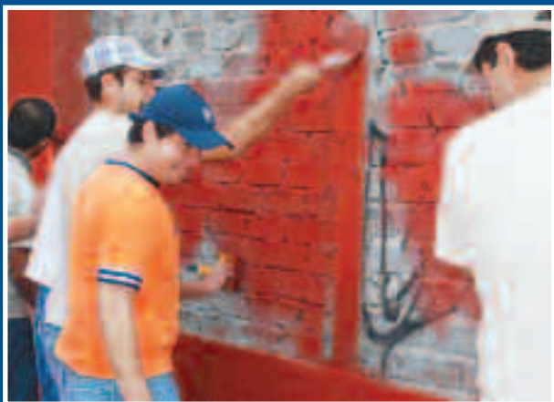
LA PINTURA DE MUROS, DE LAS ACTIVIDADES REALIZADAS.
